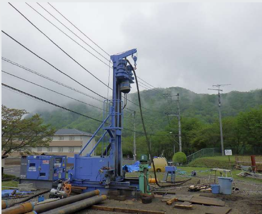
導入した設備による掘削作業の様子 硬い地盤でも井戸を掘ることが可能になった
