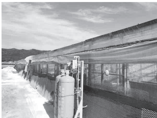
農業用ビニールハウスを改良して使用した鶏舎
